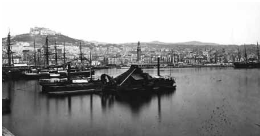
▲ La lanterna e il molo di Napoli con, sulla sinistra, la nuova Stazione marittima in costruzione. Napoli, 1936 ca. (Archivio Parisio, Fondo Troncone)
